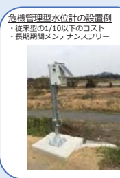
守山市川田町地先 (野洲川左岸6.8km付近)
