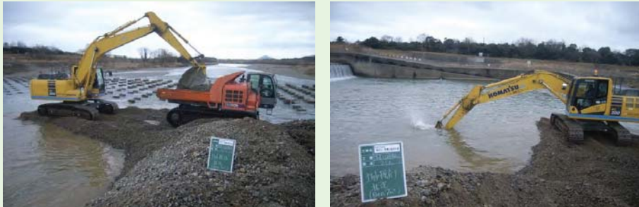
落差工下流部の河道内堆積土砂を撤去
