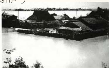
南流左岸堤決壊による洲本地先の浸水状況（現守山市洲本町）
