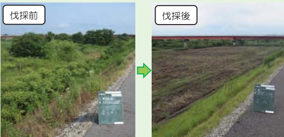
洪水の流下を阻害する樹木群の伐採
