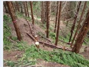
【保安林整備：本数調整伐・筋工】
