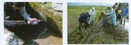
水路のひび割れ補修
