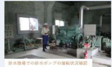
排水機場での排水ポンプの運転状況確認
