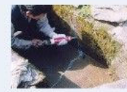
ひび割れの補修
