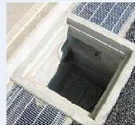
設置している雨水浸透ます
