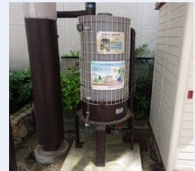
設置している雨水貯留タンク
