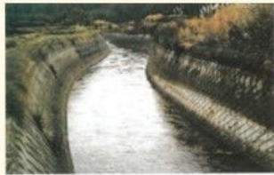
写真1-2-1 コンクリート護岸の事例
