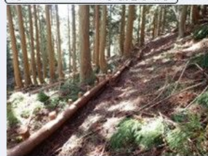
【保安林整備：本数調整伐・筋工】
