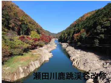
河川改修・維持管理
