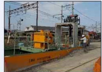
雨水整備工事の実施
