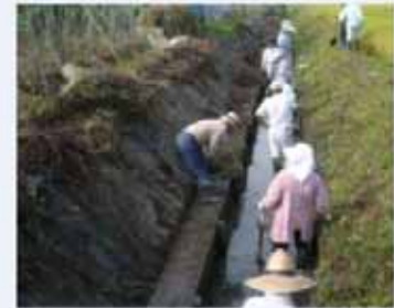
畦畔の再構築(漏水による法面前れの防止)
