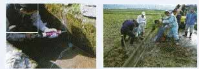
水路のひび割れ補修
