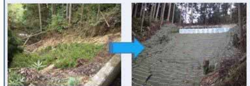
公共施設等の保全(用水路) (法面植生工)
