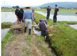
写真 堰上げ式魚道の設置の様子 (高島市マキノ町知内 R6.5.19)
