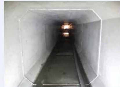
・雨水渠整備状況(殿田川) (ボックスカルバート 口1200)
