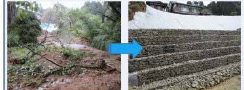
人家の保全 (鋼製土留擁壁工・法面植生工)
