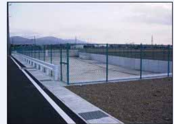
民間開発による雨水貯留施設設置
