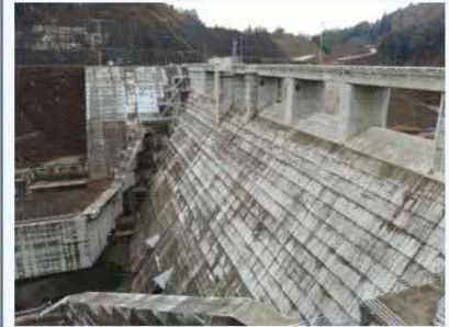
大分県：玉来ダム (R4竣工)
