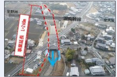
・河道掘削(山賀川)
