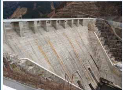
熊本県：阿蘇立野ダム (R6竣工)
