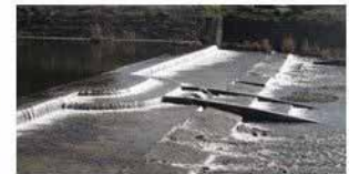
天野川岩盤地先 本格魚道
