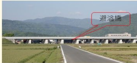
過去には県内で、新幹線や高速道路の建設時に水害リスクの変化を考慮し、盛土ではなく避溢橋にした例がある。
