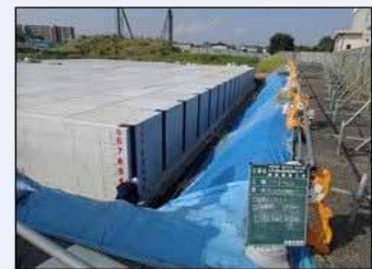
公共事業による雨水貯留施設設置
