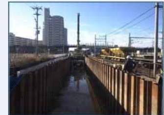
雨水BOXカルバート設置
