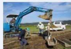
コンクリート水路の更新
