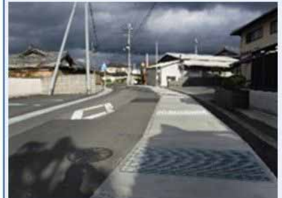
雨水対策で改良された水路
