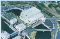
▲大同川排水機場
