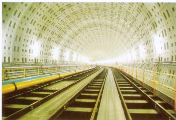
シールドトンネルの施工状況
