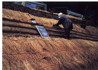
斜面緑化工完成
