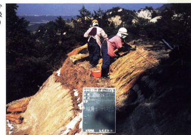
わら伏、施工中
