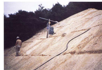
のり切り工完了 すじ付け中
