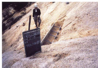
一段目ブロック板据付完了
