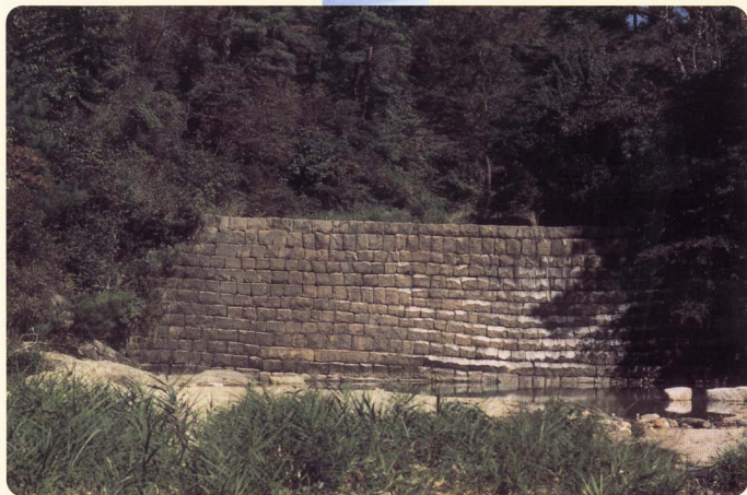
▲デ・レイケの指導のもと、日本人技術者田辺義三郎によって設計された草津川上流の「オランダ堰壁」 The "Yoro dam" constructed on the upstream of Kusatsu River by the design of Japanese engineer Gisaburo Tanabe, under the instruction of J. de Reijke.
