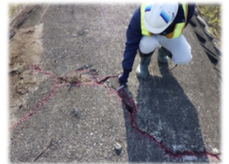
護岸の亀裂の確認状況
