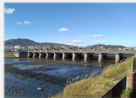
全閉の本堰（令和5年12月22日撮影）
