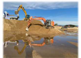
堆積土砂の撤去
