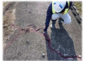
護岸の亀裂の確認状況
