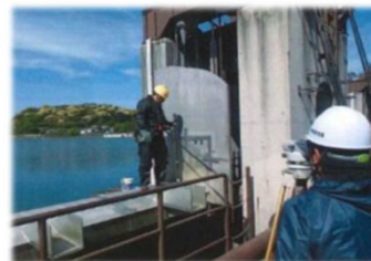
洗堰ゲート設備の点検
