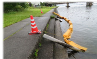
油流出事故対応（オイルフェンス設置）状況
