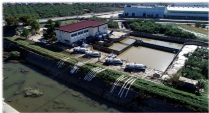
千曲川（長野県）での排水作業(R1.10)
