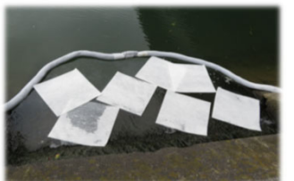
油流出事故対応（オイルフェンス設置）状況
