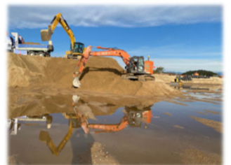
堆積土砂の撤去
