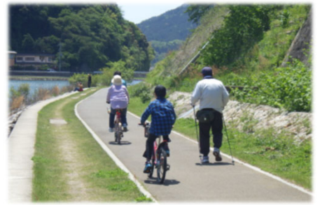
高水敷利用状況
