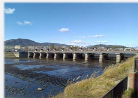
全閉の本堰 (令和5年12月22日撮影)
