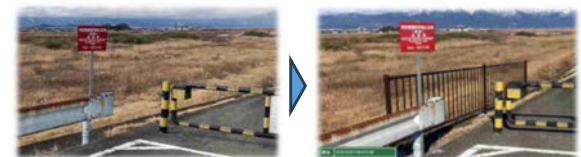
転落防止柵設置状況
