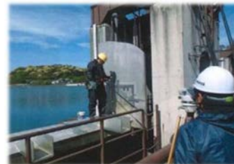
洗堰ゲート設備の点検
