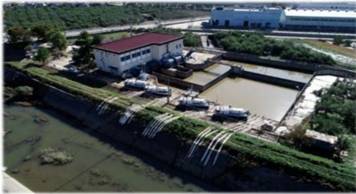
千曲川（長野県）での排水作業(R1, 10)
