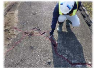
護岸の亀裂の確認状況
