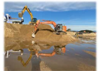
堆積土砂の撤去
