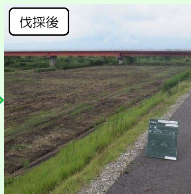
洪水の流下を阻害する樹木群の伐採
