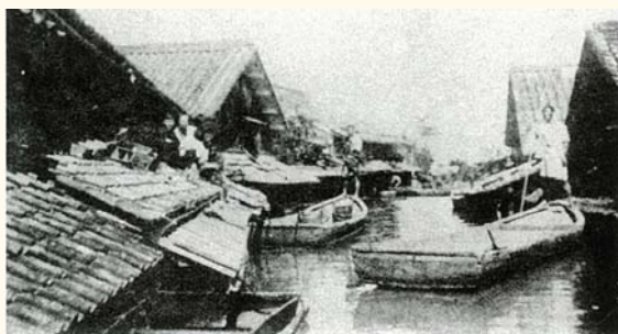
野洲郡北里村江頭の冠水状況
