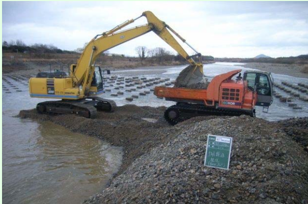
落差工下流部の河道内堆積土砂を撤去
