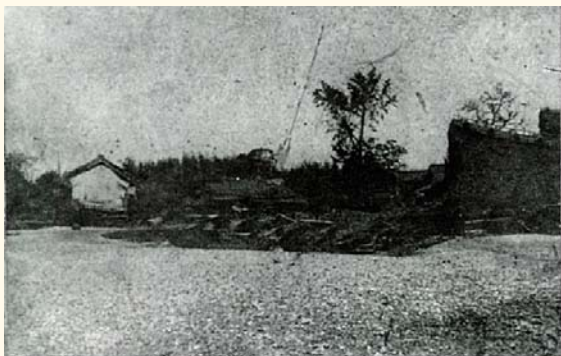
屋根裏まで土砂に埋まる惨状（中洲村新庄）
