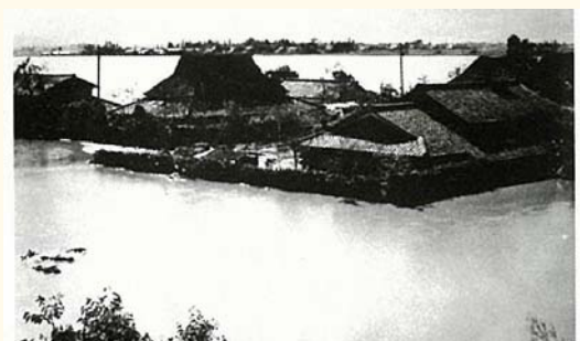
南流左岸堤決壊による洲本地先の浸水状況
