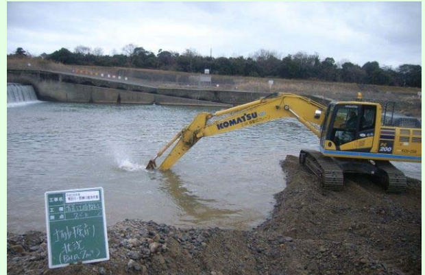
落差工下流部の河道内堆積土砂を撤去
