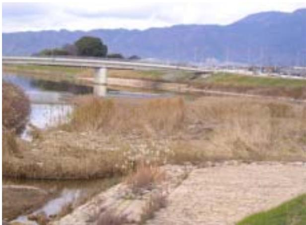
合流点の剣先に自然石のステージを整備、前面に自然植生が見られる。護岸は多自然式の巨石積護岸となっている。(前の橋は庄司田橋)
