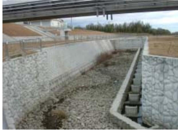
右岸川魚道。写真の左側は緩勾配(多自然型)。右側はアイスハーバー型。左岸側には傾斜導壁型が設置してある。
