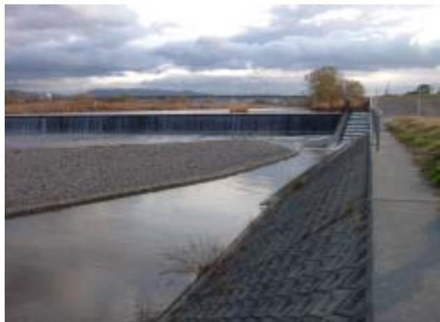
左岸魚道(階段式で下流側に淵がある)
