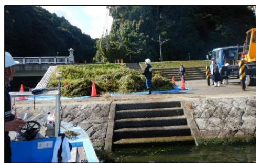
水草揚陸・仮置き場所(瀬田川左岸73.2k付近)
