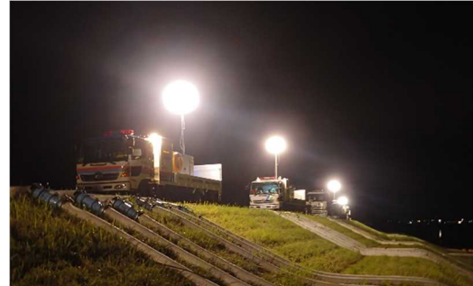
京都府福知山市 排水作業(H30.7)
