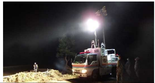
南越前町被災現場 照明車支援(R4.8)
