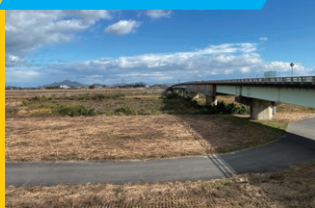
野洲川新庄大橋(平常時)
