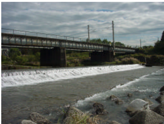
写真⑨ H15. 11. 12、 JR北陸本線直下の床止め工、河川流量減少より床固め工の遡上が容易でない状況。なお、この落差工の両端の魚道では、ジャンプでとび越えていった親魚もいた。(目視確認)
