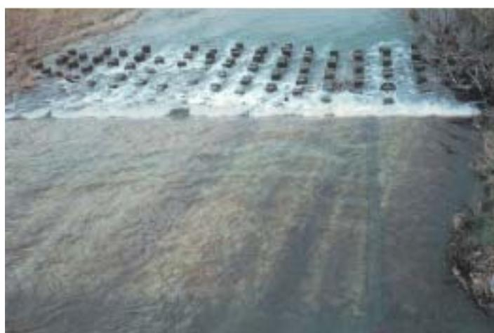
写真-2 田川カルバート上部の護床工
