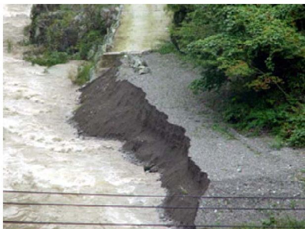
写真-8 土砂流下状況 H16. 10. 11 (放流量＝約40m 3 /s)
