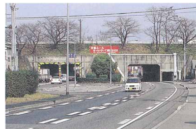
図-1 国道1号線と草津川(草津市)
