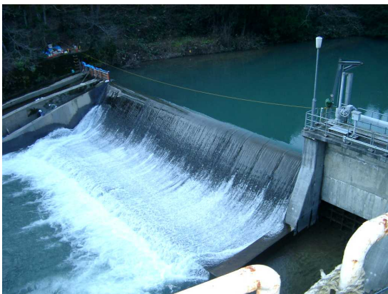
写真-11 大見堰堤(20.2km 付近)
