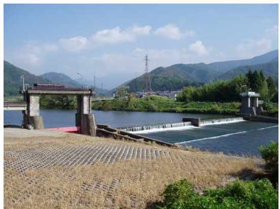
写真-10 高時川頭首工(13.8km 付近) [昭和 43 年完成]
