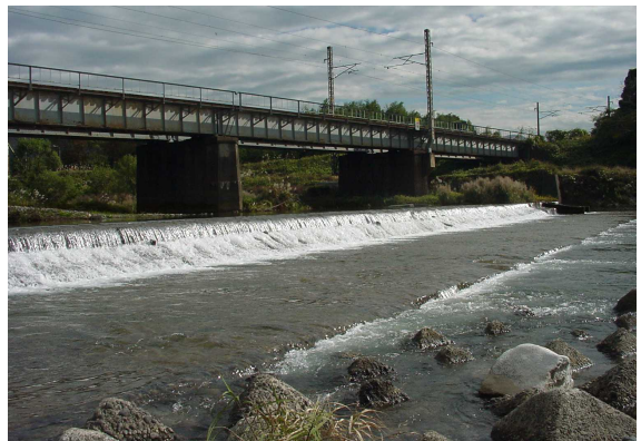
写真-8 床止工(JR 直下)(9.2km 付近)
