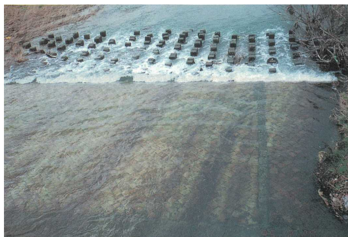
写真-2 田川カルバート上部の護床工
