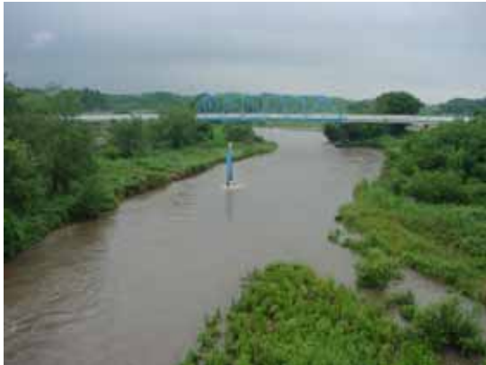
写真-12 新福橋下流
