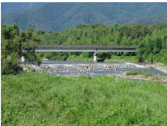
写真-9 床止工(雨の森)(12.1km 付近)
