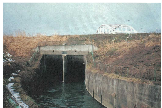
写真-1 田川カルバート(上流側から)
