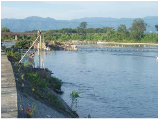
写真-5 下流ヤナ(0.8km 付近)
