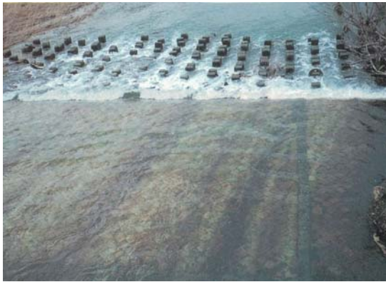
写真-7 田川カルバート(高時川)(3.8km 付近) [昭和 41 年完成]
