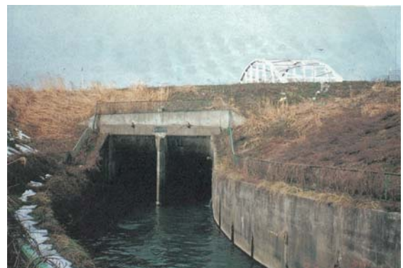
写真-1 田川カルバート(上流側から)
