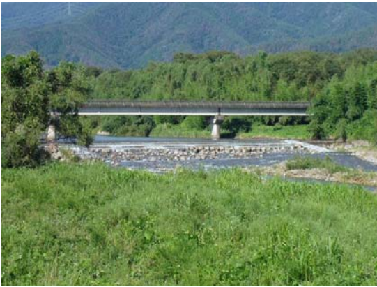
写真-9 床止工(雨の森)(12.1km 付近)
