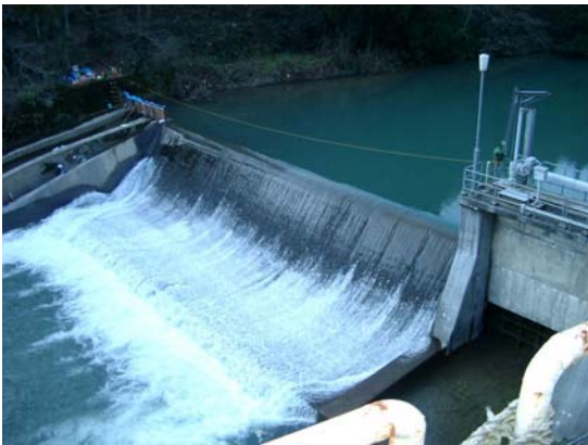
写真-11 大見堰堤(20.2km 付近)
