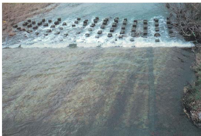
写真-2 田川カルバート上部の護床工
