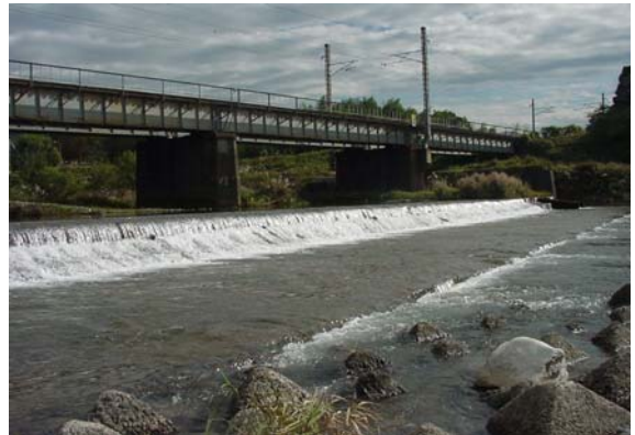
写真-8 床止工(JR 直下)(9.2km 付近)
