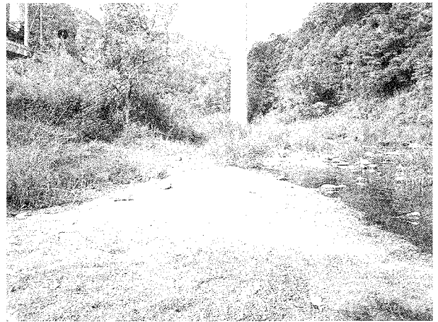
平成15年8月（対策後）
