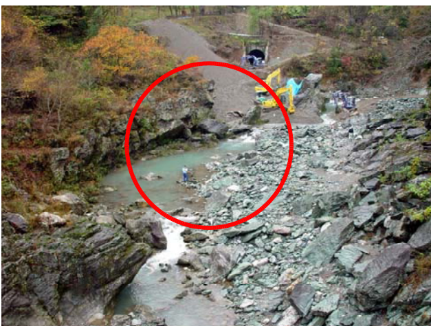
写真-12 叢石橋上流 H16.6撮影
