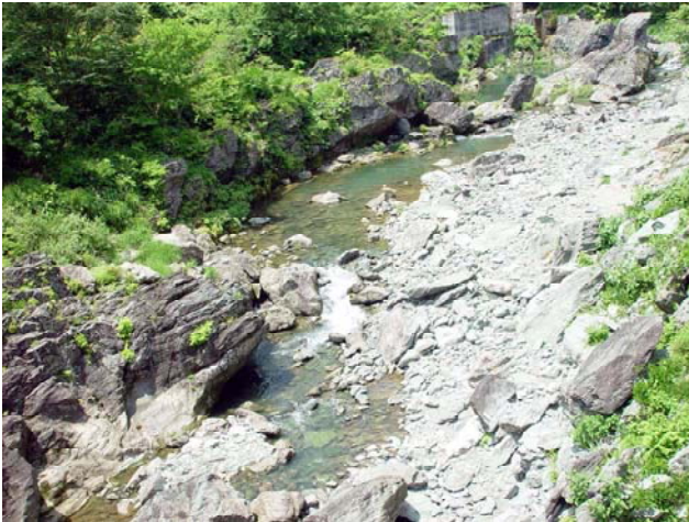
写真-10 叢石橋上流 H15.5撮影
