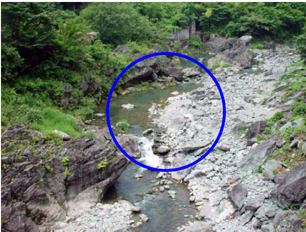
写真-11 叢石橋上流 H16.6撮影
