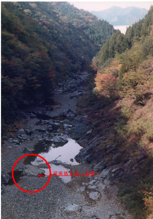
写真-6 三波石峡下流 (ダム建設直後)
