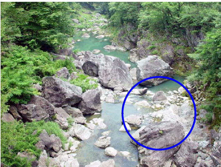
写真-14 叢石橋下流 H16.6撮影
