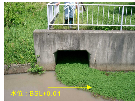
北側堤脚水路 BOX
