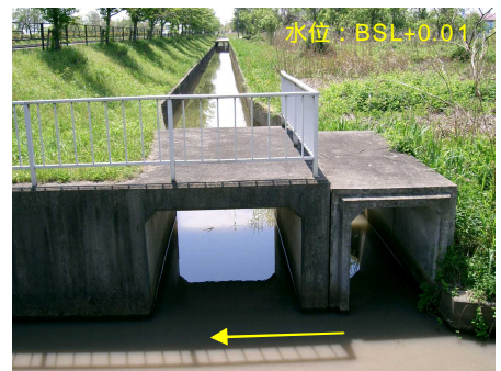
南側堤脚水路 BOX
