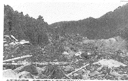
土石流の現場。左端に壊れた住宅の残骸があり、右奥の土砂ダムには作業用の重機が点在していた
