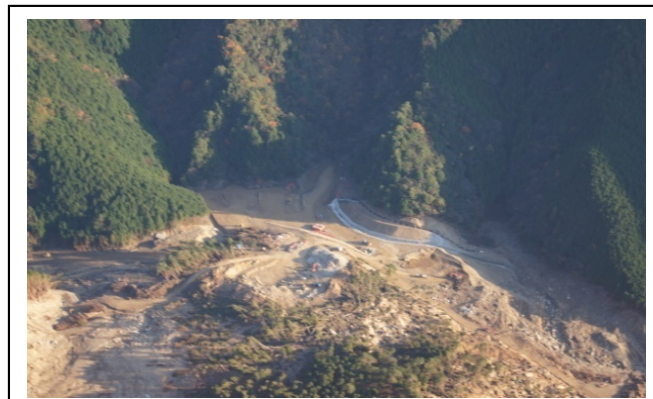
埋め立て完了状況（12月5日）
