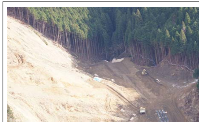
埋め立て完了状況（12月20日）
