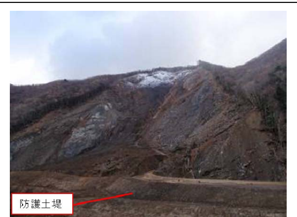
防護土堤設置状況（12月9日）
