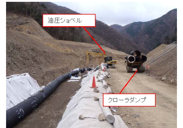
仮排水路設置状況（12月20日）
