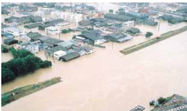
新川破堤状況
