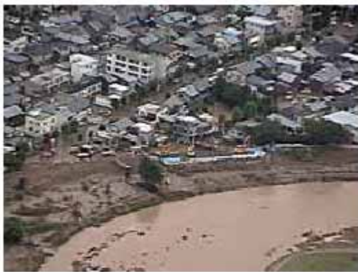
足羽川 破堤箇所状況
