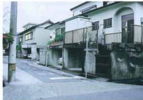
高知県伊野町枝川 1975、76年の水害のあとに建った住宅です。高床にして、車庫に用いている住宅が並んでいます。
