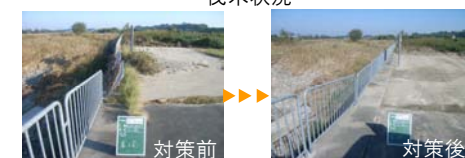
補修（転落防止柵）状況
