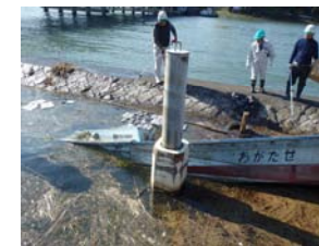
油流出事故対応（オイルフェンス設置）状況
