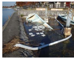
油流出事故対応（オイルフェンス設置）状況
