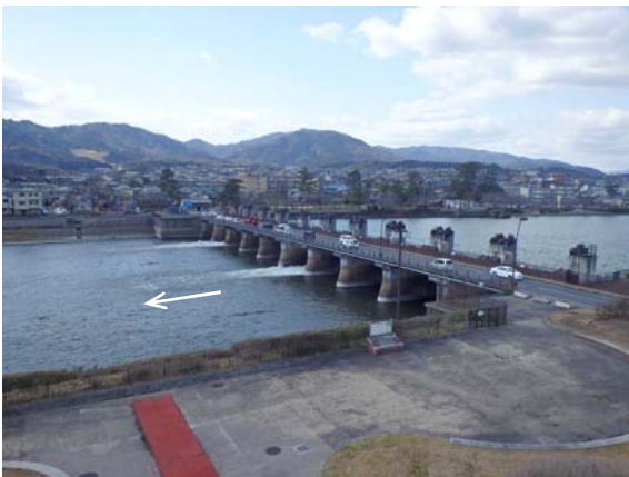
瀬田川洗堰放流状況
