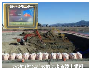
ICT建機による施行状況
