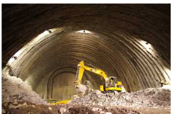
トンネル上半部掘削中 (H30.2)
