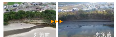
応急復旧状況（林地区）
