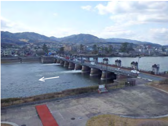
瀬田川洗堰放流状況
