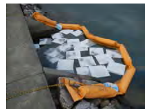
油流出事故対応（オイルフェンス設置）状況
