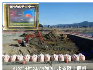
ICT建機による施行状況
