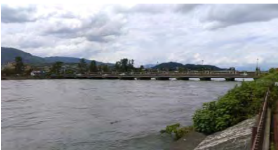
全開時下流から見た洗堰 (平成30年7月8日13時頃)
