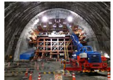
トンネル上半部覆工状況(H30.10)
