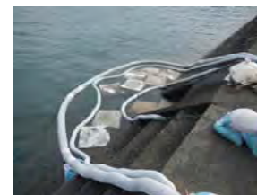
油流出事故対応（オイルフェンス設置）状況
