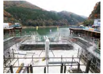
コンクリート打設状況(H30.12)
