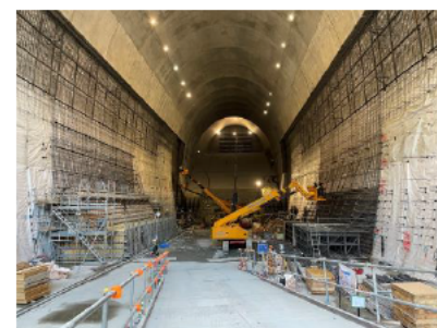
トンネル下半部覆工状況(R3.2)
