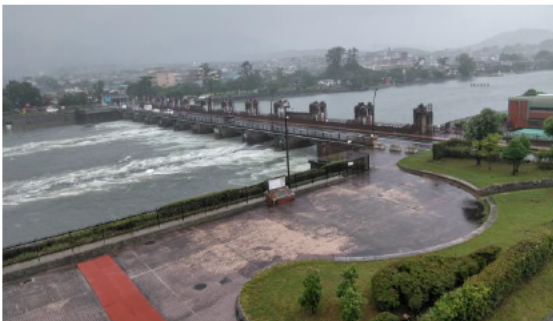
中間操作時の洗堰（令和2年7月14日撮影）
