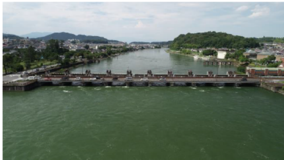
全開放流時の洗堰（令和2年7月19日撮影）
