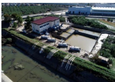
千曲川（長野県）での排水作業（R1. 10）
