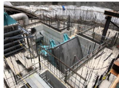
主ゲート据付状況(H30.8)
