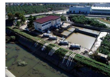
千曲川（長野県）での排水作業(R1.10)
