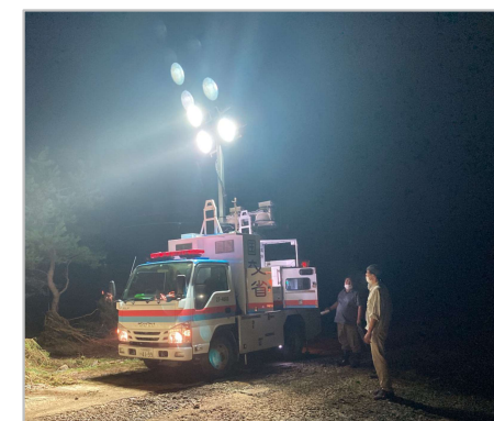
照明車の出動状況 (福井県南条郡南越前町,R4.8.5)
