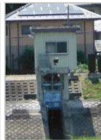
立木第二樋門
