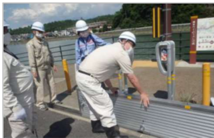
〈千町陸閘でのゲート設置状況〉
