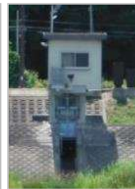
立木第三樋門
