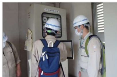
〈前田樋門操作状況〉
