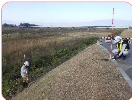
▲ 堤防点検の様子
