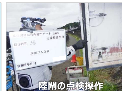
洗堰ゲート設備の点検
