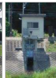
立木第三樋門
