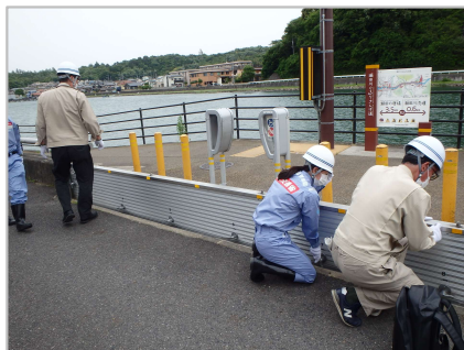
〈千町陸閘でのゲート設置状況〉
