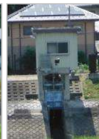
立木第二樋門
