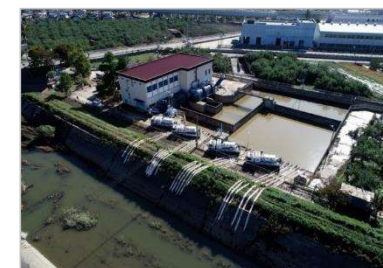
千曲川（長野県）での排水作業(R1.10)
