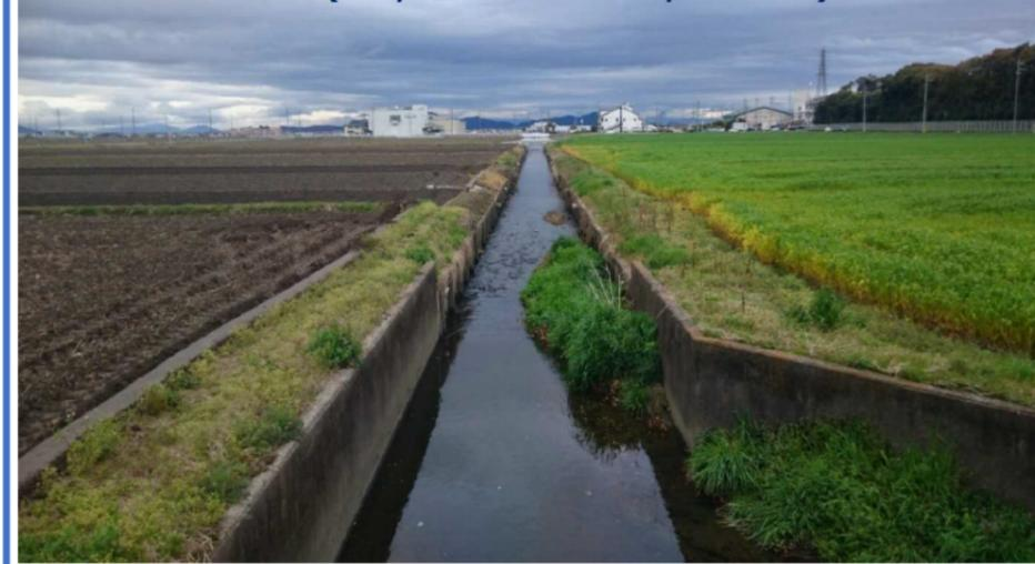
**着工後状況** 鉄筋コンクリート製耐震U型水路
