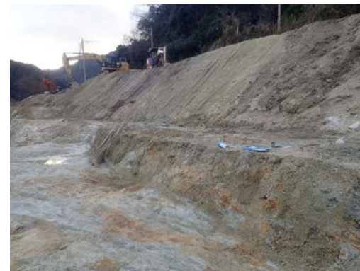
【③大型ブレーカ工法の掘削面】
