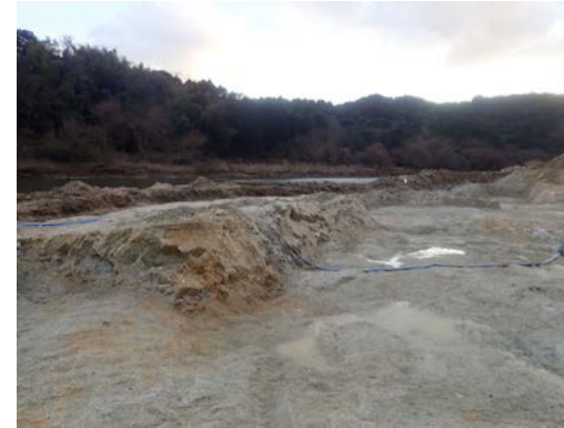
【②静的破碎剤工法の掘削面(平水位以上)】
