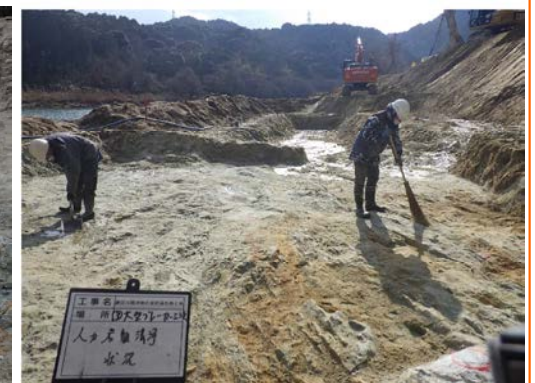
【②静的破碎剤工法の掘削面(平水位以上)】
