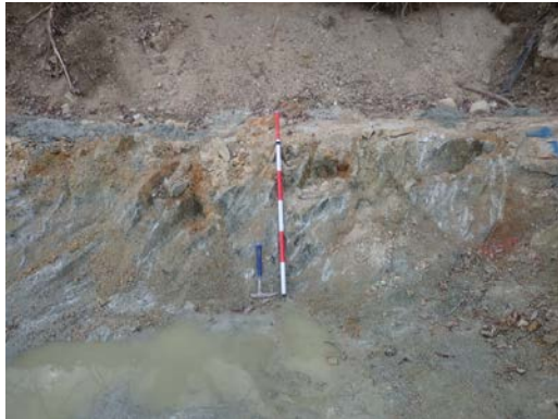
【①油圧クサビ割岩工法の掘削面】
