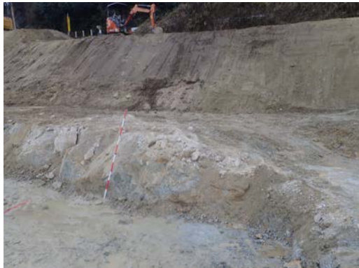
【②静的破碎剤工法の掘削面(平水位以下)】
