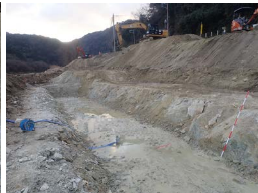
【②静的破碎剤工法の掘削面(平水位以下)】
