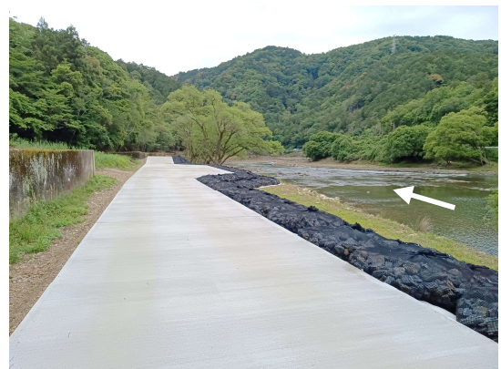
令和7年3月完成 工事用道路
