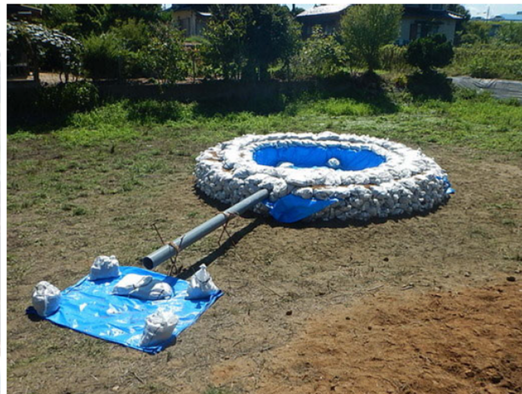
完成した釜段工
