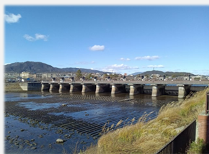
全閉の本堰(左)と必要最小限の水を下流に放流するパイパス水路(右) (令和5年12月22日撮影)
