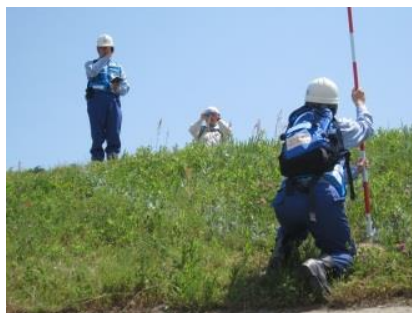
TEC-FORCEの被災状況調査
