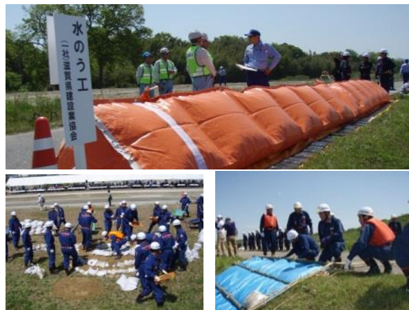
水防工法訓練（漏水、洗堀、越水対策）
