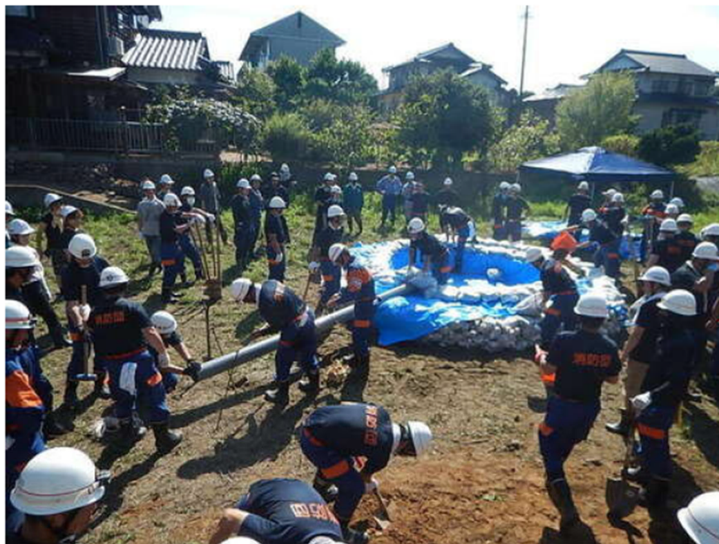
土のう約500個を使用して作製
