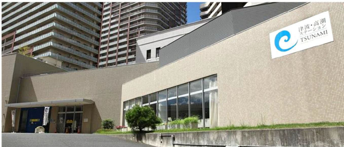
「津波・高潮ステーション」外観
