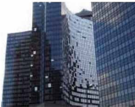
ハリケーン・カトリーナによる高層ビルの窓ガラスの破損
