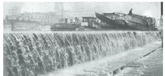
写真 2.2.5 堂島川の被害(大阪市)
