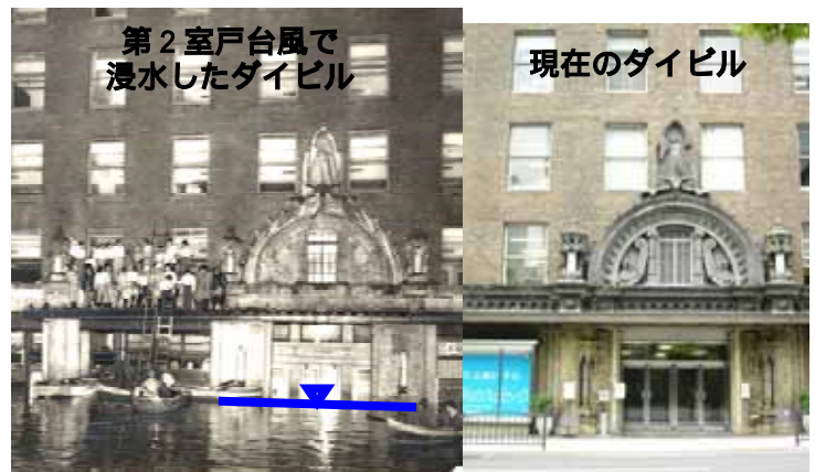
写真 2.2.6 ダイビルの浸水状況
