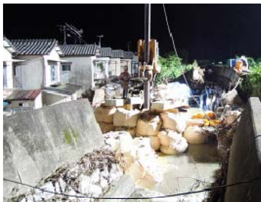
矢板施工状況 (8/18 21:00頃)
