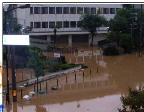
福知山市内の浸水状況
