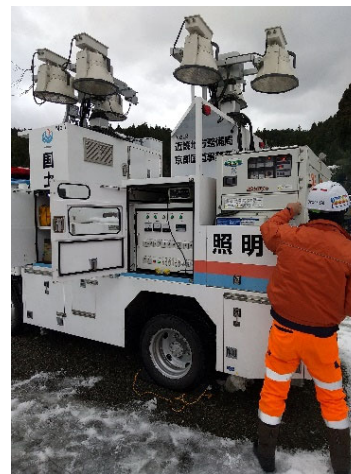
【電源支援班】富山防災センター 作業状況（16日）
