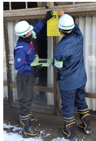
【営繕班】能登町 作業状況（16日）
