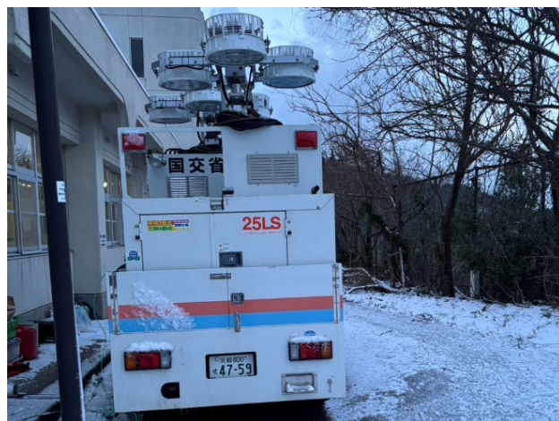
【電源支援班】輪島市、珠洲市他 作業状況（24日）
