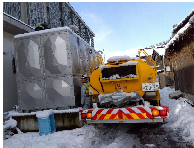
【給水班】輪島市他 作業状況（24日）
