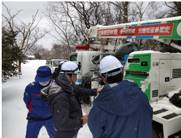
【電源支援班】珠洲市 作業状況（25日）
