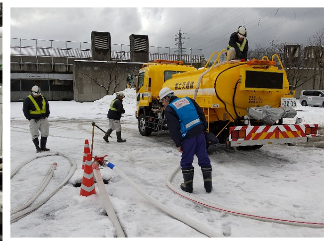
【給水班】金沢市 作業状況（25日）
