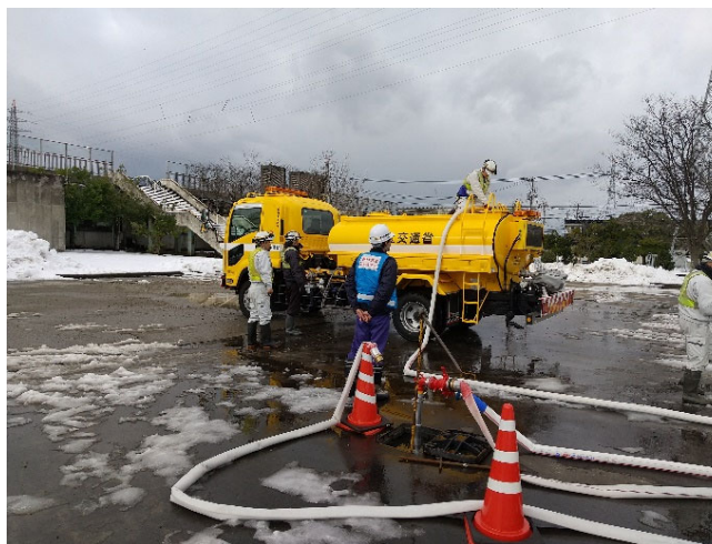
【給水班】金沢市 作業状況（27日）
