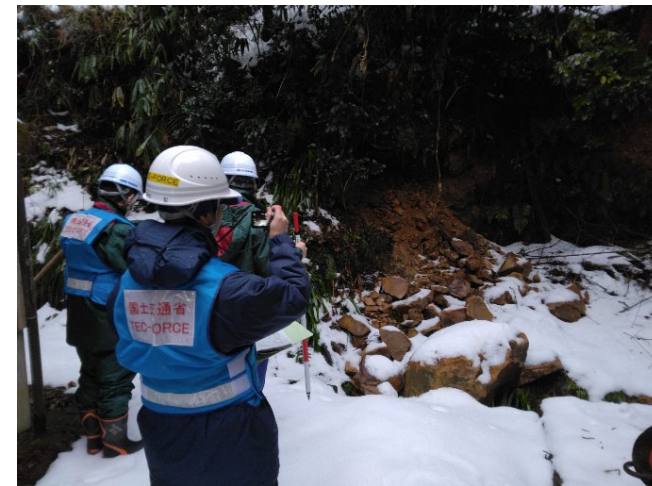
【砂防班】珠洲市 作業状況（27日）
