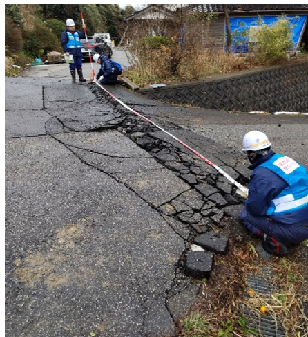
【市町道調査班】珠洲市 作業状況（27日）
