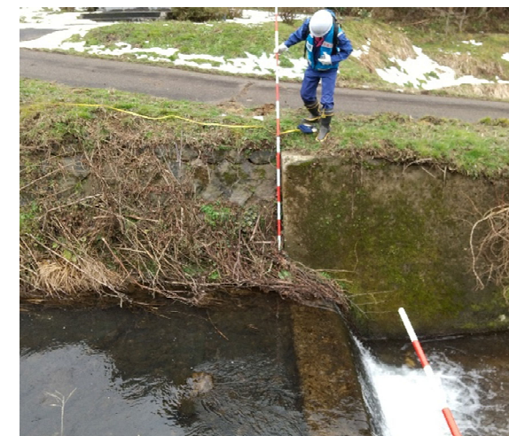
【河川班】輪島市 作業状況（2日）
