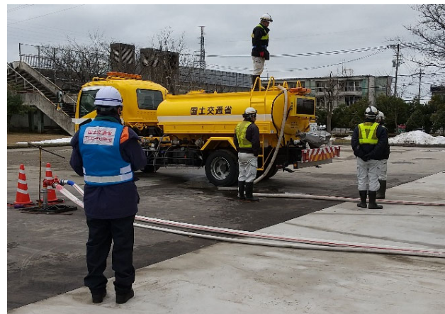
【給水班】金沢市 作業状況（2日）
